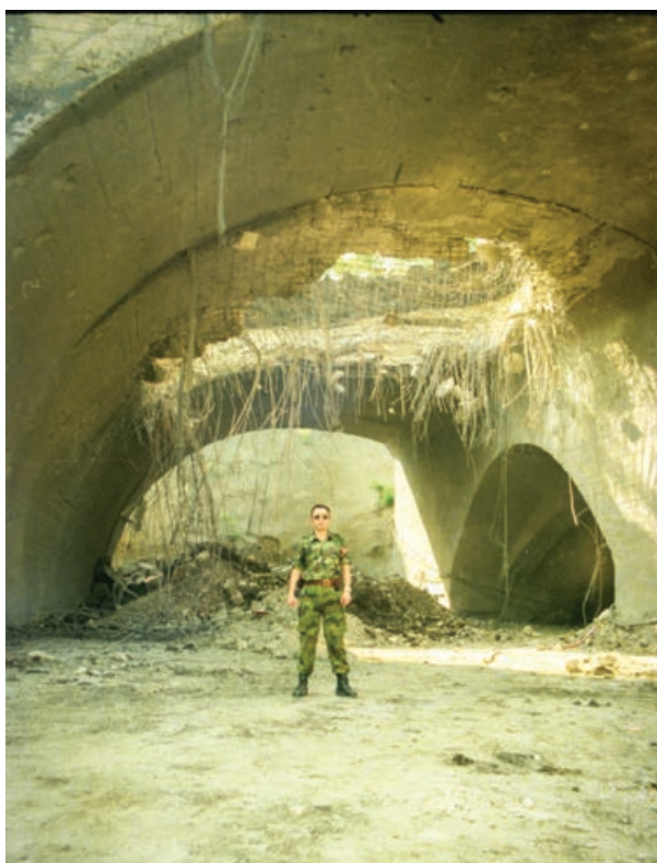
Ulaz u „Rudnik“ sa severne strane – luk je probijen pogotkom bombe GBU-28, najjače iz američkog arsenala u to doba
